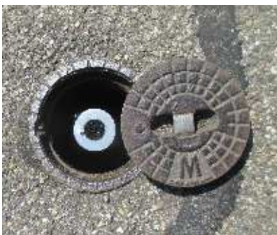
BASTA Kleinste Öffnung der Straßenkappe für Größe A mindestens 80 mm \varnothing Größe B mindestens 120 mm \varnothing
